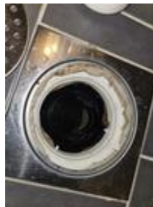
Plastsluk med mansjett og klemring
