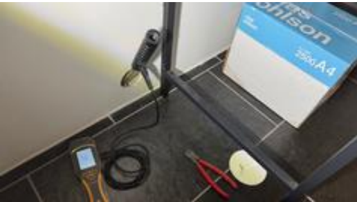
7,6 vekt% i yttervegg under trapp for hoveddel.
