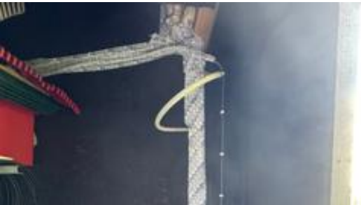
Uisolert vannledning i bod.
