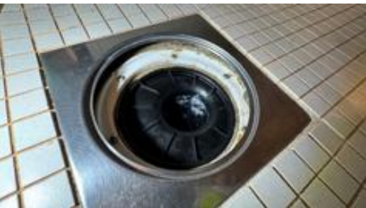
Synlig membran under slukens klemring.
