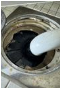
Synlig membran under slukens klemring.
