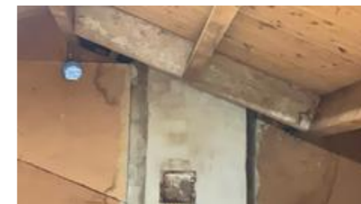
Pipe ved takgjennomføringen.
