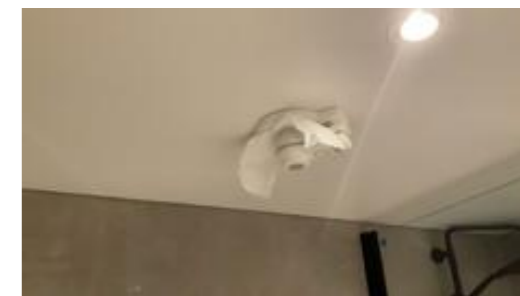
Vifte funksjonstestet med papir.
