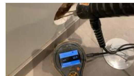
Fuktsøkt i vegg uten unormale forhold.
