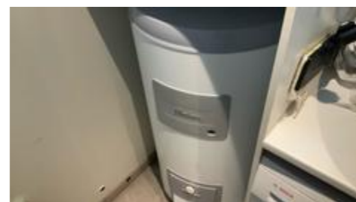
Varmtvannsbereider
