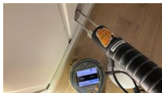
Fuktsøkt i vegg uten unormale forhold.
