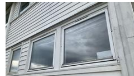
Råteskadet vinduer.
