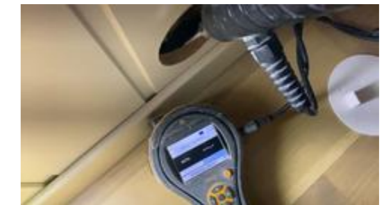
Fuktsøkt i vegg uten unormale forhold.
