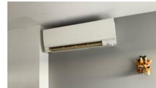
Varmepumpe luft/luft
