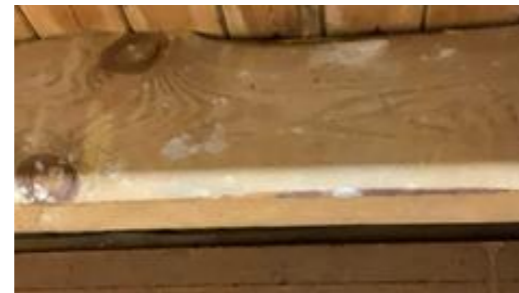
Flyvehull og boremel etter morr/borebiller.
