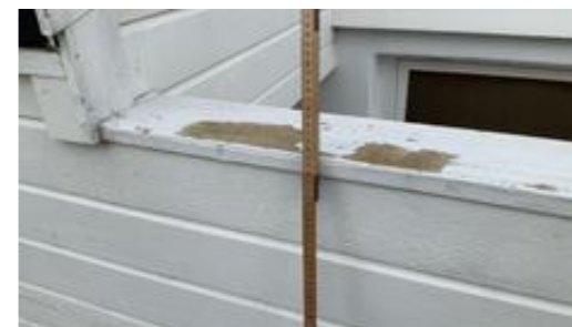
Lavt rekkverk på kjellertrapp.
