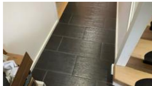
Deler av gulv med fliser.
