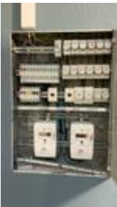
Boligens sikringsskap er plassert i fellesgang. Kurser med automatsikringer.
