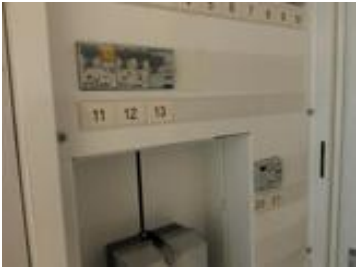
Sikringsskap med automatsikringer.
