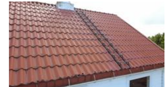
Fast montert takstige til en pipe
