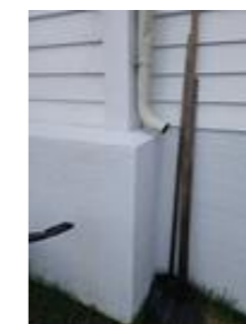
Takvannet ledes til terrenget ved grunnmuren
