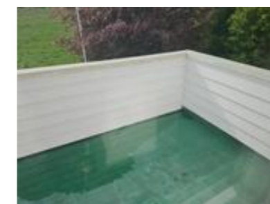
Veranda / terrasse teknet med glassfiber. Rekkverk av tre
