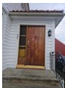
Hoveddør. Ikke beslag eller tetting i underkant
