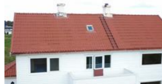
Taket er tekking med metallplater
