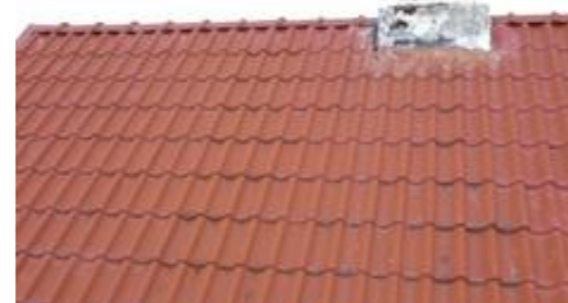
Taket er tekking med metallplater
