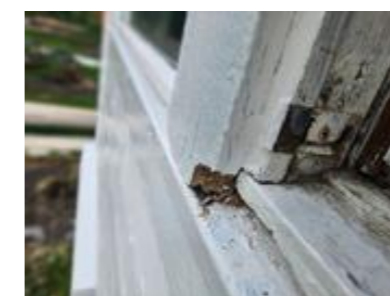
Slitt vindu. Begynnende råteskade på utvendig omraming
