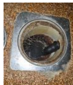
Sluk med forhøyningsring av plast
