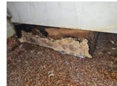
Fuktskadede sokke
