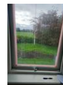
Slitt vindu. Begynnende råteskade på utvendig omraming
