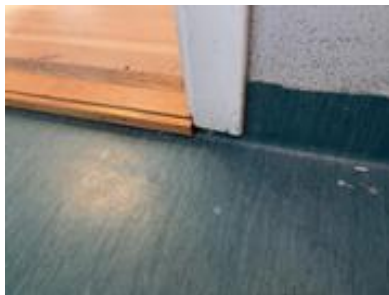
Gulvbelegg med oppbrett mot veggene, og mot den ene døren
