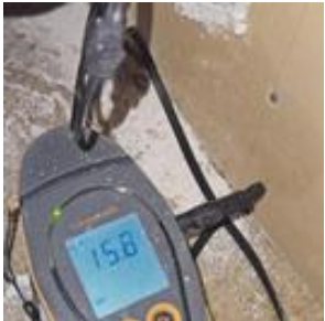
Ingen indikasjon på unormal fukt i veggen
